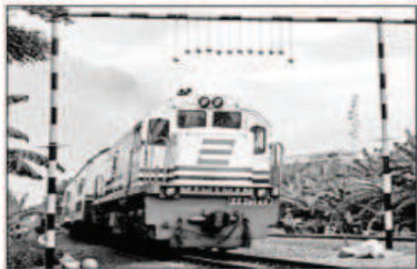
GEFÄHRLICH: Die Betonkugeln schweben knapp einen Meter über den Zügen. Sie sind lebensgefährlich.
